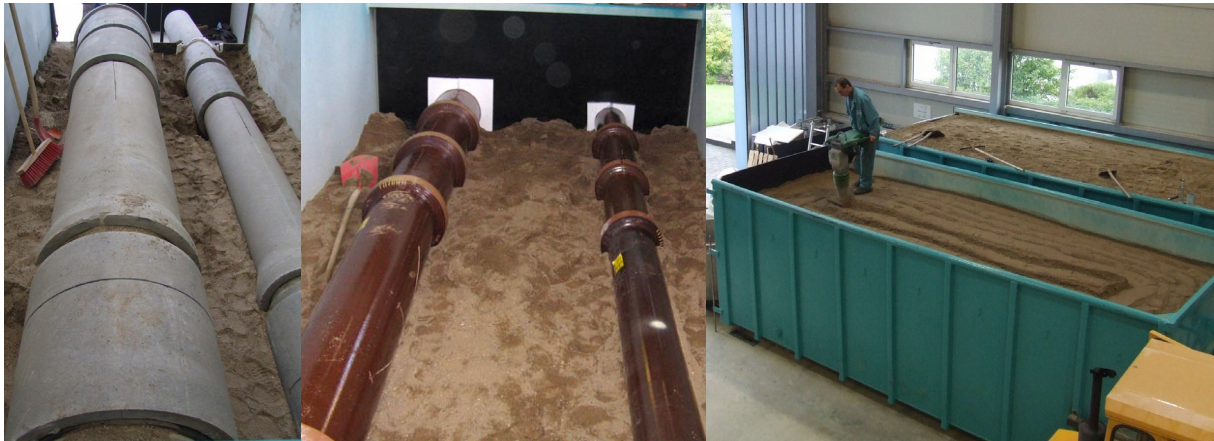
Abb. 1: Teststreckenaufbau für die Injektions- und Spachtel-/Verpressverfahren
